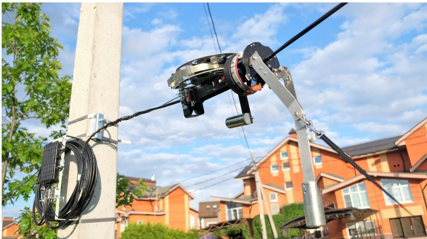
Навивочная машинка WF-350P используется для укладки на несущий элемент тонкого оптического кабеля в виде спирали, охватывающей несущий элемент – ОКСН (диаметром до 25 мм), СИП (4x16, 4x25, 4x35 мм<sup>2</sup>), или диэлектрический трос.
