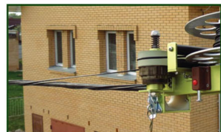
Жгут (6) из кабелей навитых на несущий элемент (ОКСН, трос) и очередной навиваемый кабель
