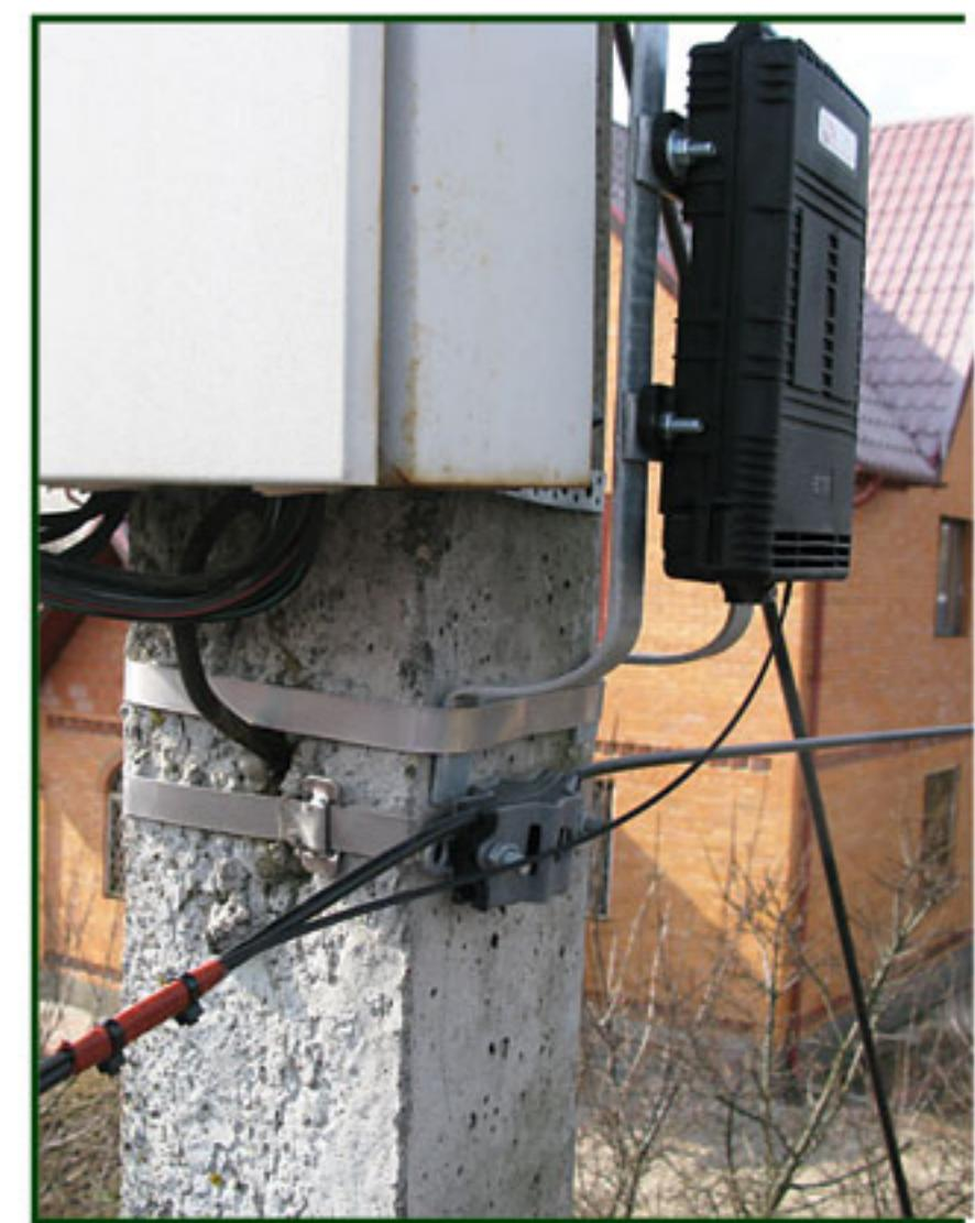
Дроп-муфта с кронштейном (7) на опоре и комплект фиксации (3) распределительного навивного кабеля к несущему тросу
